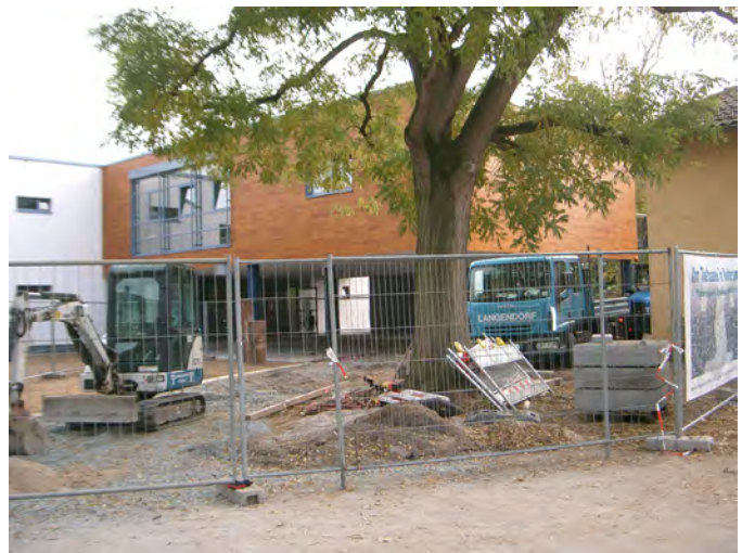
Es wird gebaut.
