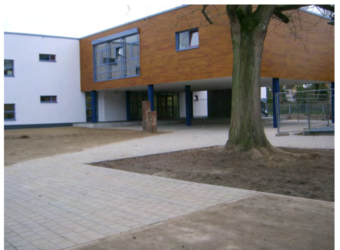
Das Pflaster ist da!!
