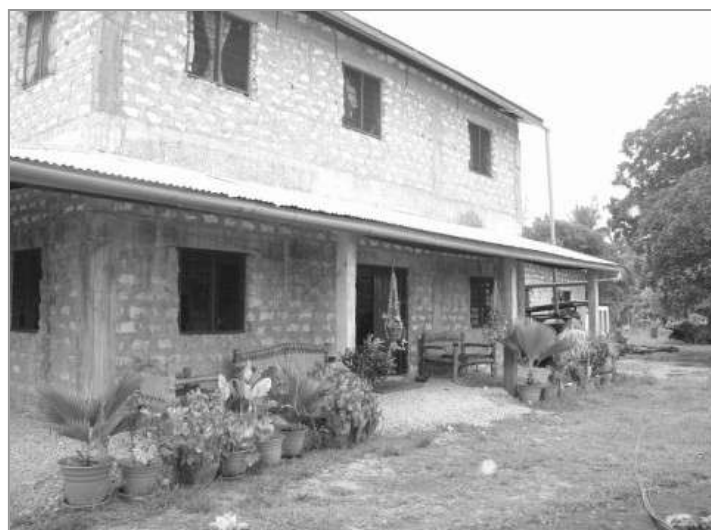
Das noch nicht ganz fertige Waisenhaus in der Nähe von Mombasa.
