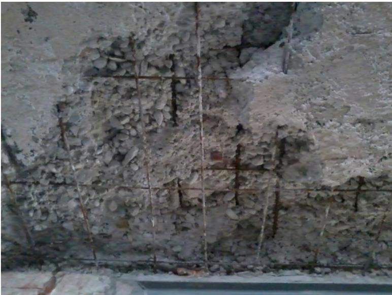
Die Sanierung der Betondecke erfordert viel Arbeit. Denn die Decke muss an einigen Stellen verstärkt werden. Hier ist die Armierung zu sehen, die beim Abklopfen des lockeren Materials frei gelegt wird. Beim Bauen in den 50er-Jahren wurde zu wenig Zement verwendet. Foto: B.Gabel, Architekturbüro Lorenz
